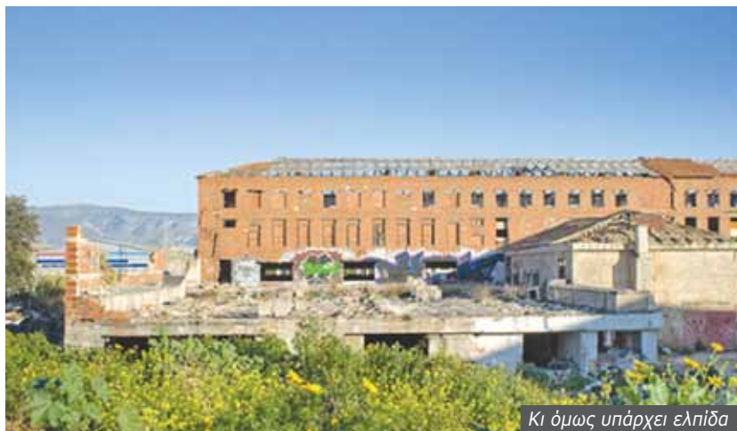
Κατεδάφιση προ των πυλών
